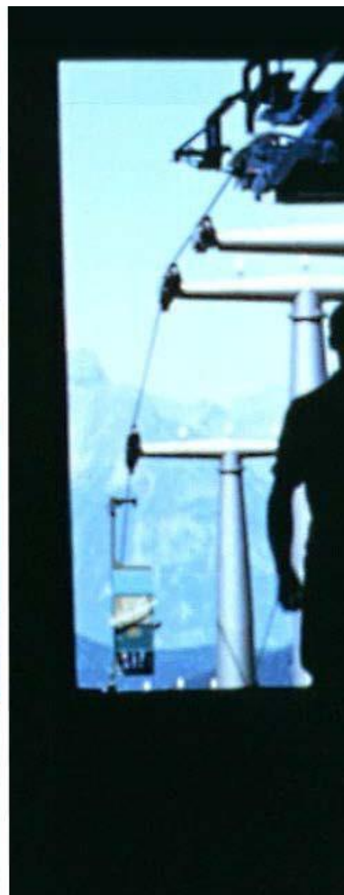
Une fois désolidarisée du câble, un employé arrête la benne pour laisser descendre ses passagers. (DR Roland Muller, Médiathèque Valais - Martigny)
