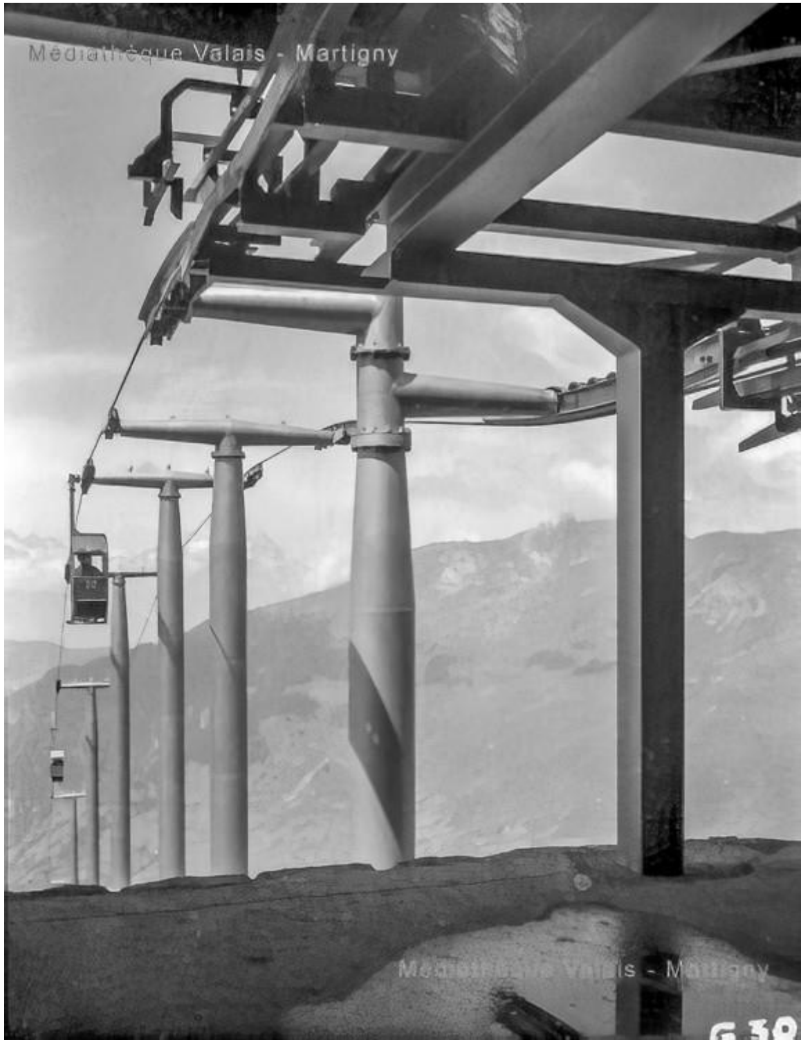
La fin de la ligne depuis le ralentisseur. Nous remarquons le rail de déverrouillage ainsi que le volet de sécurité. (DR Charles Paris, Médiathèque Valais - Martigny)
