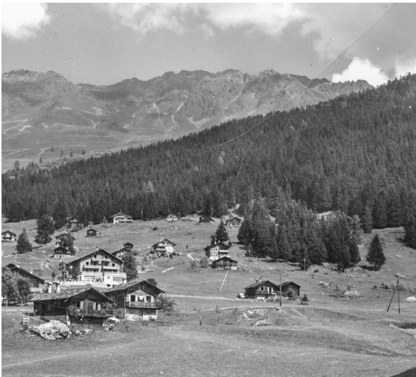
La station aval et sa ligne à travers les sapins. (Commune de Bagnes - DR Gyger & Klopfenstein Adelboden)
