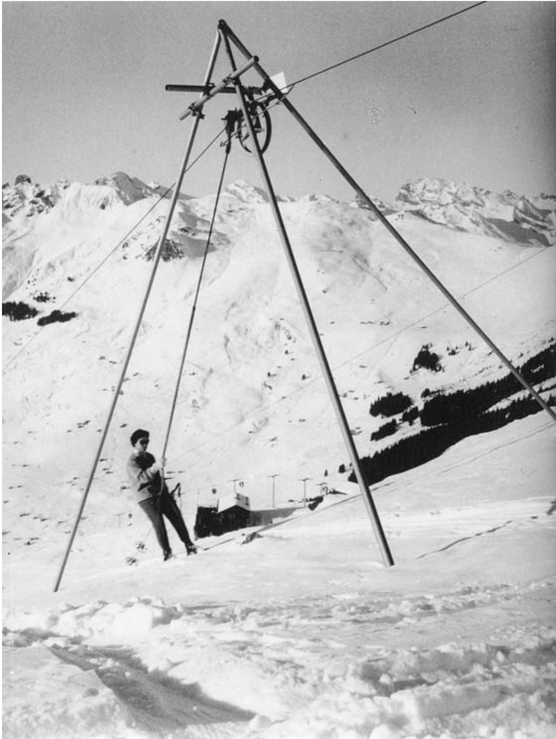
Une skieuse arrivant bientôt au haut de la Tête. Giovanola livrera en décembre de cette même année le téléski type B sur les pentes de Soussillon, dans le Val d'Anniviers, reprenant la gare légère Poma Baby haubanée et des ouvrages de ligne à trépied sans fondation équipant déjà les Ruinettes. Un troisième et dernier appareil inauguré le 27 décembre 1951 à Caux sera équipé de pylônes légers. (DR Téléverbier SA)
