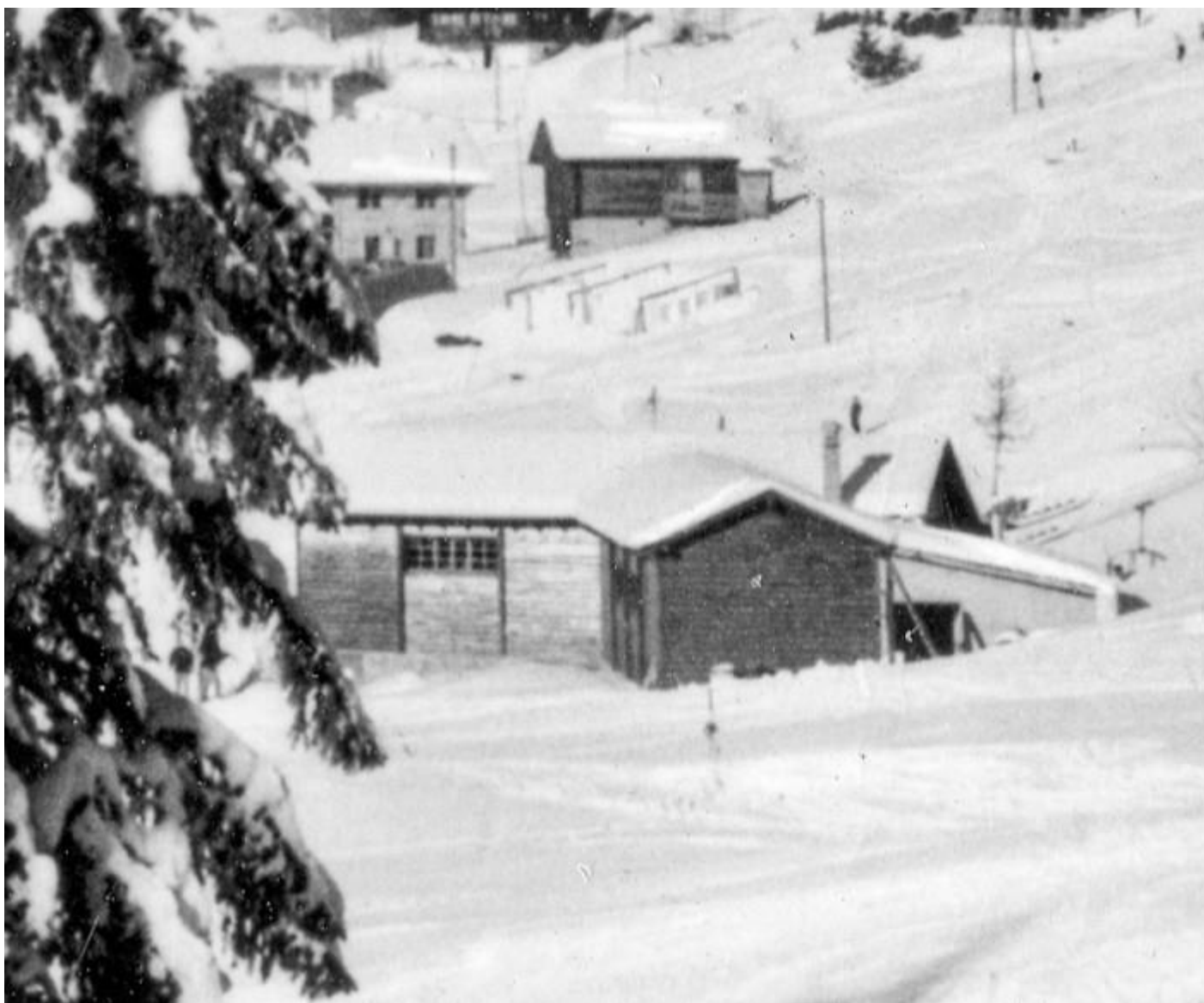
La gare aval sous son manteau de neige. Un cabanon utilisé pour le rangement est bâti à l'avant du garage. (Collection Julien Beaud - DR)
