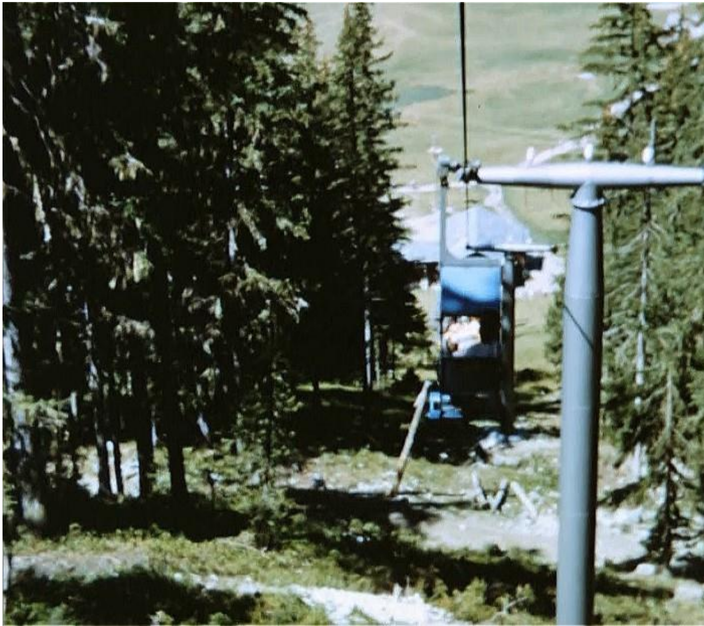
Le huitième pylône précédant le second pylône de compression de la ligne imprimant une pente plus prononcée. (DR Henri-Charles Golay, Médiathèque Valais - Martigny)
