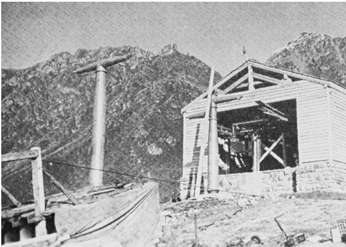
La station des Ruinettes en construction. (DR Téléverbier SA)
