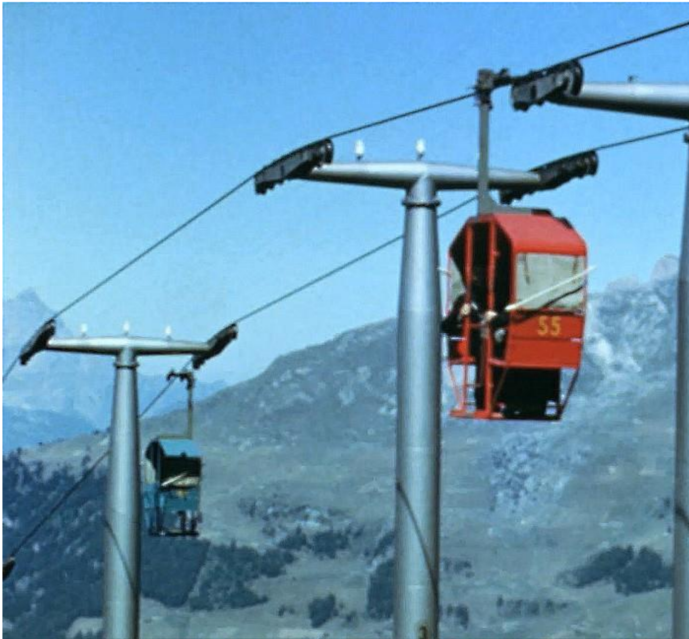
Une cabine sur le pylône n°31, avant-dernier pylône, depuis la gare amont. (DR Roland Muller, Médiathèque Valais - Martigny)
