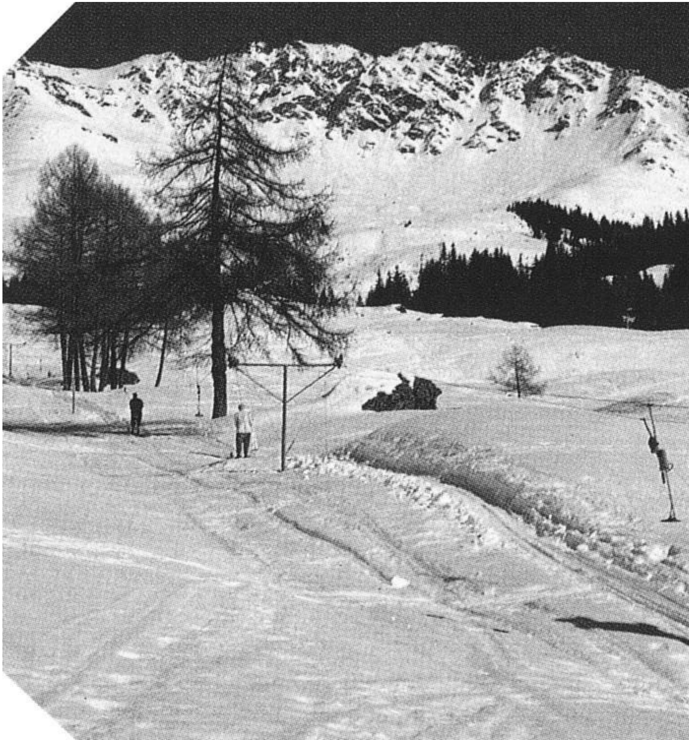
La première partie de la seconde section, peu avant le passage à travers quelques sapins. Des câbles tendus depuis le sol stabilisent les pylônes. (DR Téléverbier SA)
