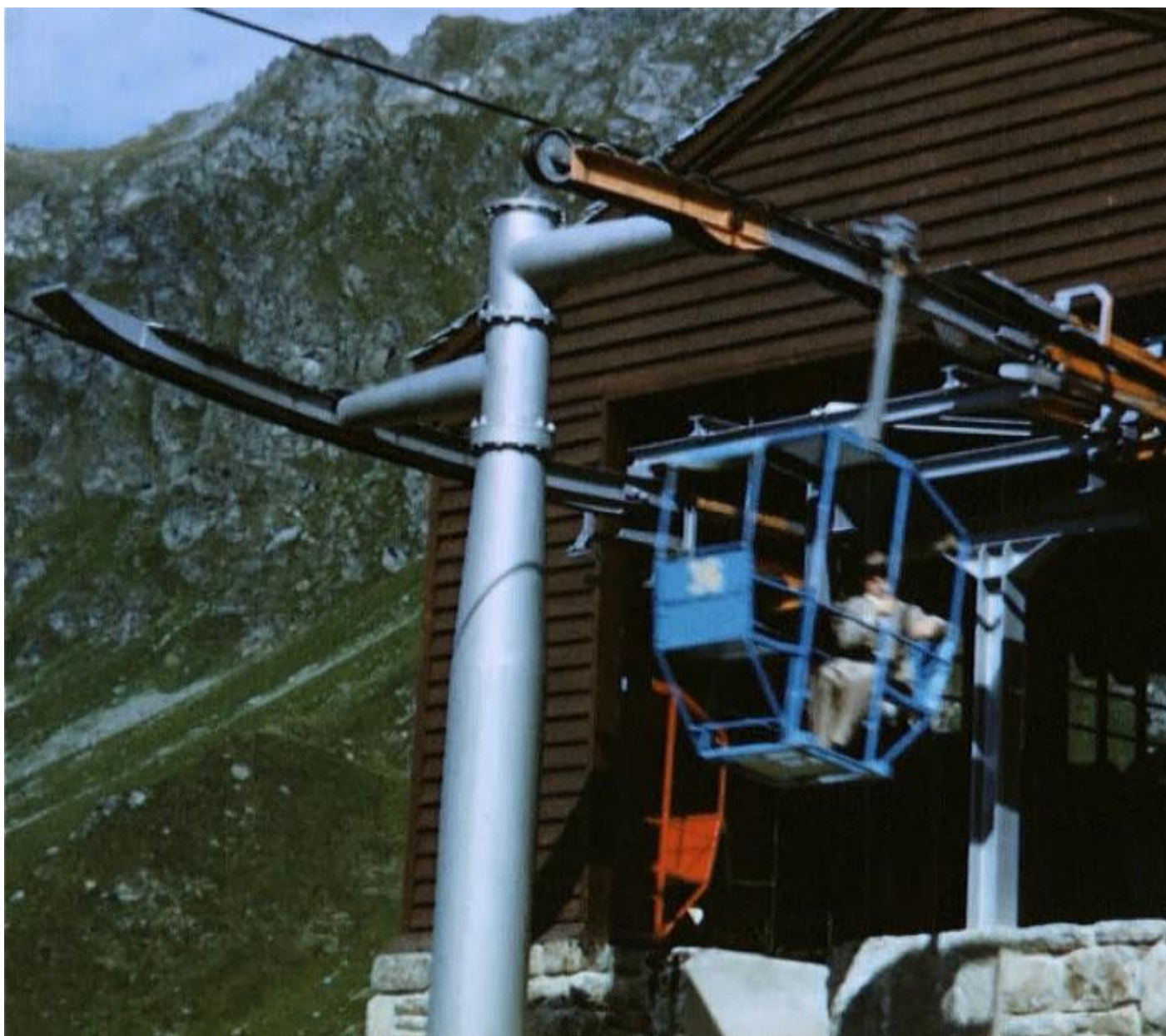
L'utilisation de la pesanteur pour le lanceur impliquant un rail de sortie plus bas, le pylône n°30, lié à la gare, se compose d'un balancier support pour le brin montant ainsi que d'un rail de compression pour le brin descendant. (DR Henri-Charles Golay, Médiathèque Valais - Martigny)
