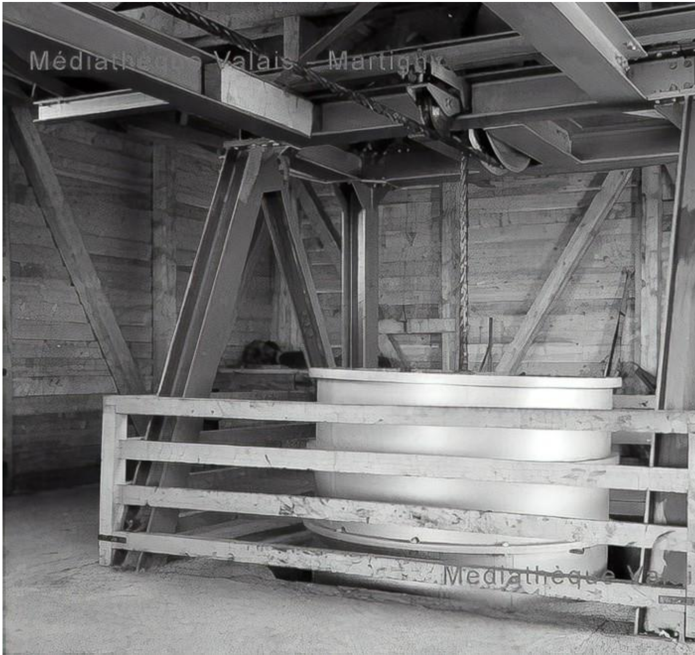
La fosse du contrepoids en forme de baril au-devant du contour. (DR Charles Paris, Médiathèque Valais-Martigny)
