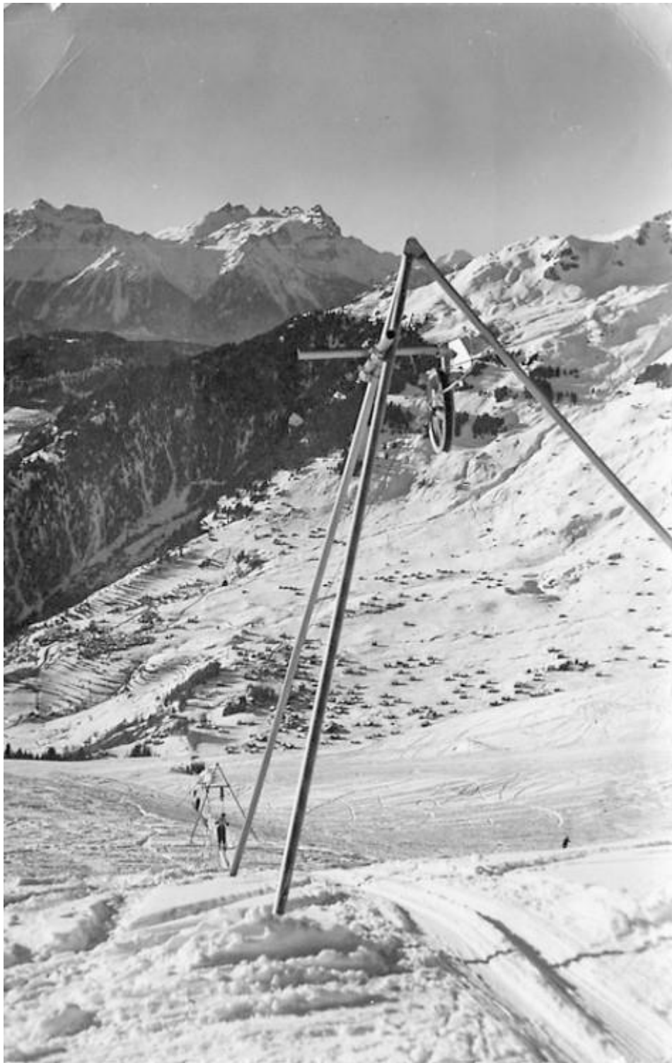
La courte ligne au complet depuis la gare amont. (DR)
