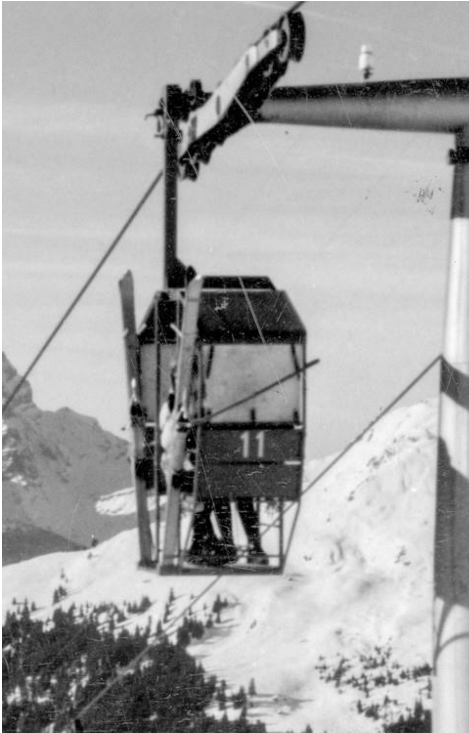
Lors de la saison hivernale, un porte-skis est installé sur la face latérale extérieure. (Collection Julien Beaud - DR Darbellay Martigny)
