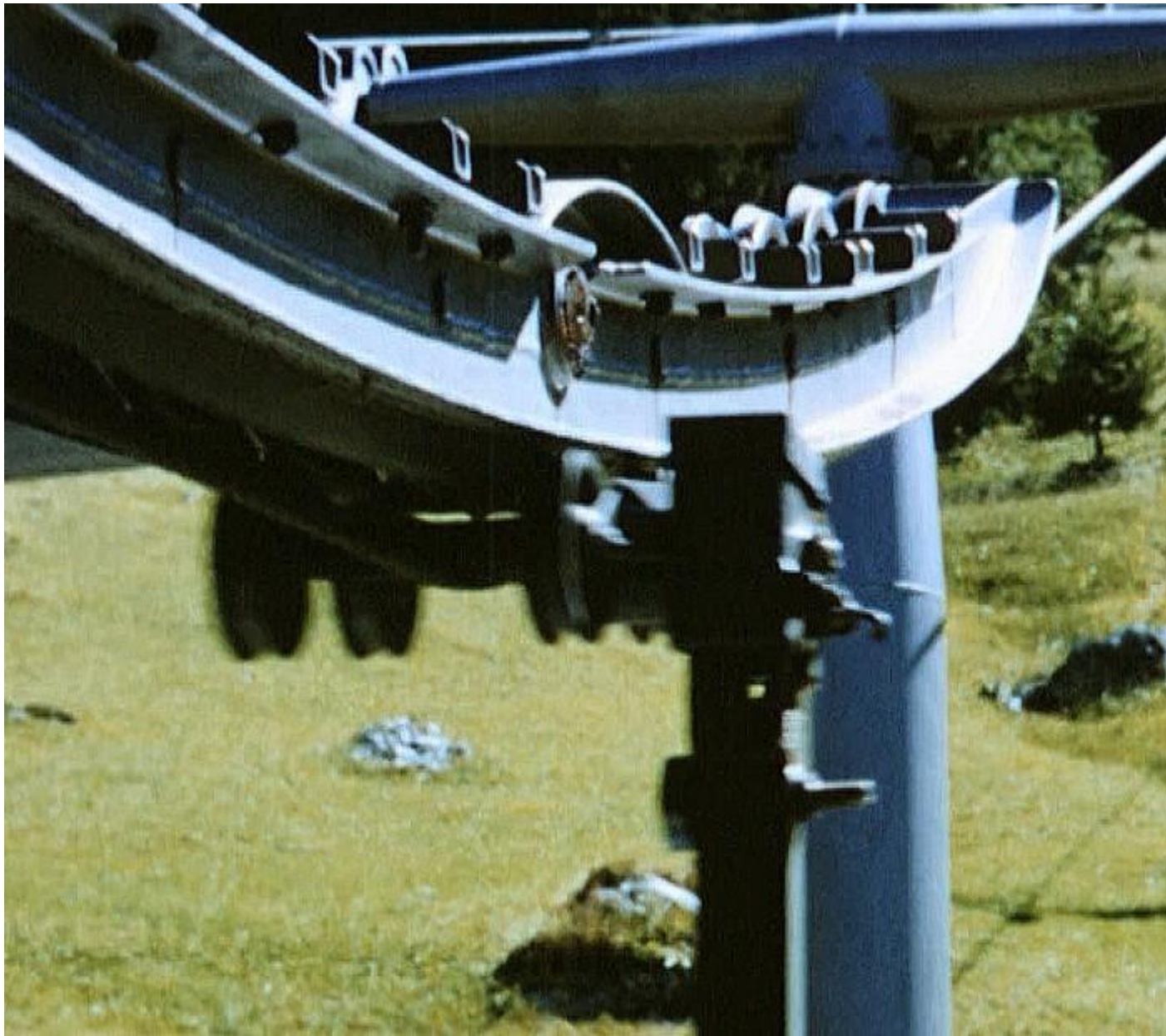
La conception de la pince n'autorise pas le passage de pylônes compressions conventionnels. Un rail de guidage permet au châssis de rouler, en dégageant légèrement le câble des galets. (DR Henri-Charles Golay, Médiathèque Valais - Martigny)
