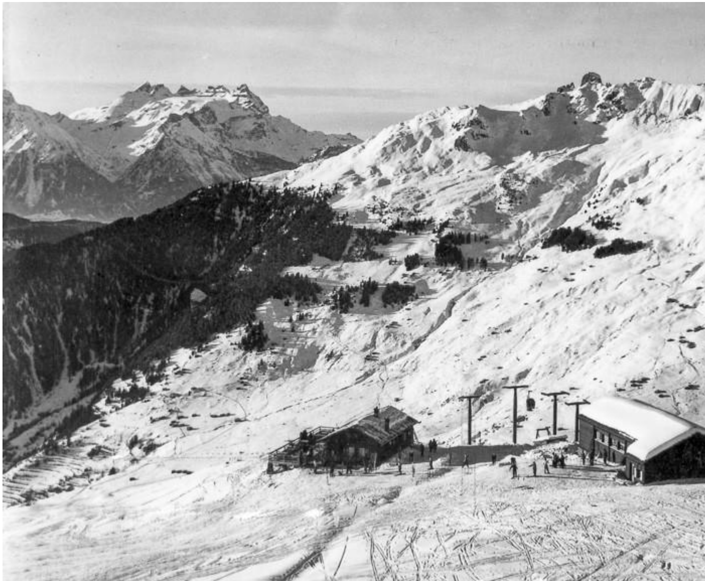
La station des Ruinettes face à la Pierre à Voir. (Commune de Bagnes - DR Darbellay Martigny)
