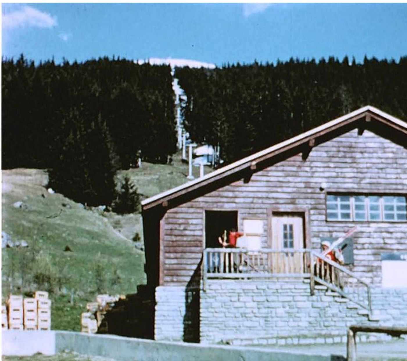
La station de départ et la ligne. Un escalier mène les futurs voyageurs aux deux entrées ; la porte de gauche conduit préalablement les clients aux guichets. (DR Denis Bertholet, Médiathèque Valais - Martigny)
