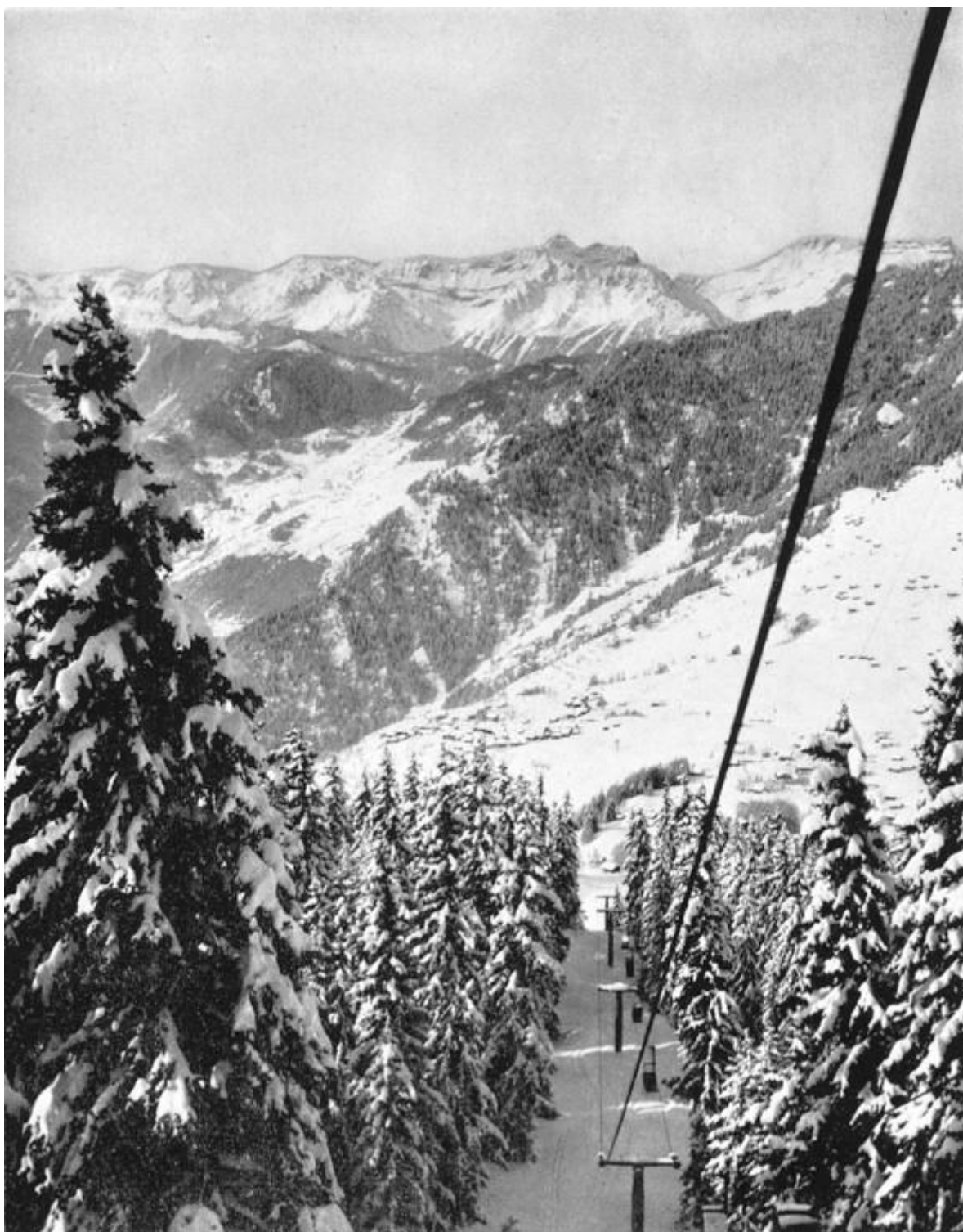
La ligne peu après le passage sous le troisième pylône de compression. (DR Téléverbier SA)
