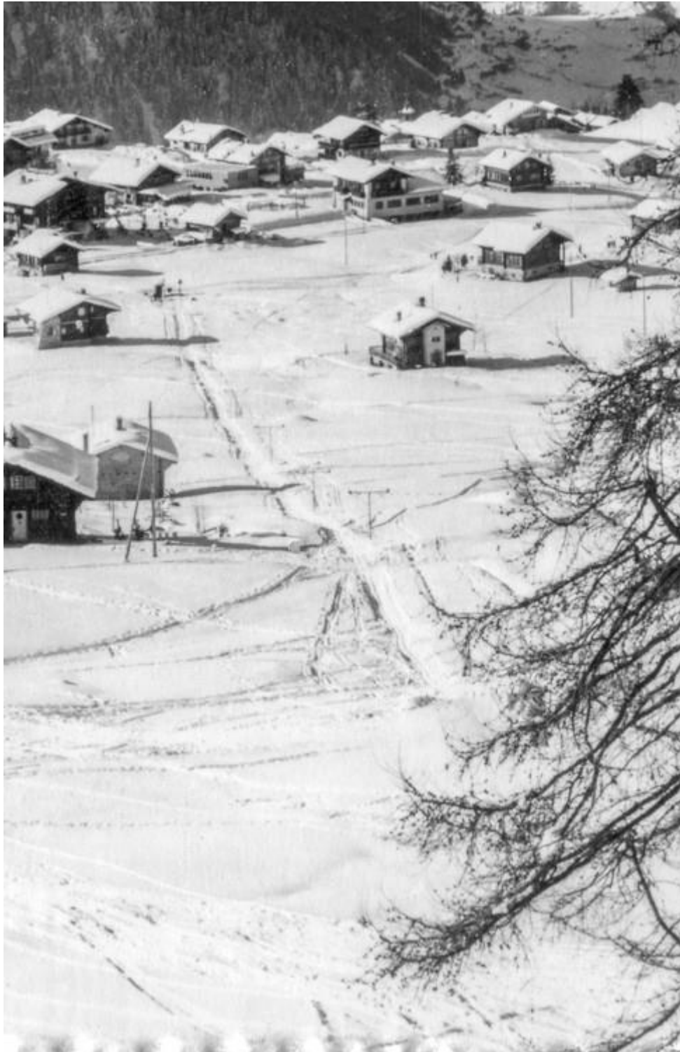
Le premier tronçon vu depuis l'amont. (Collection Julien Beaud - DR Darbellay Martigny)
