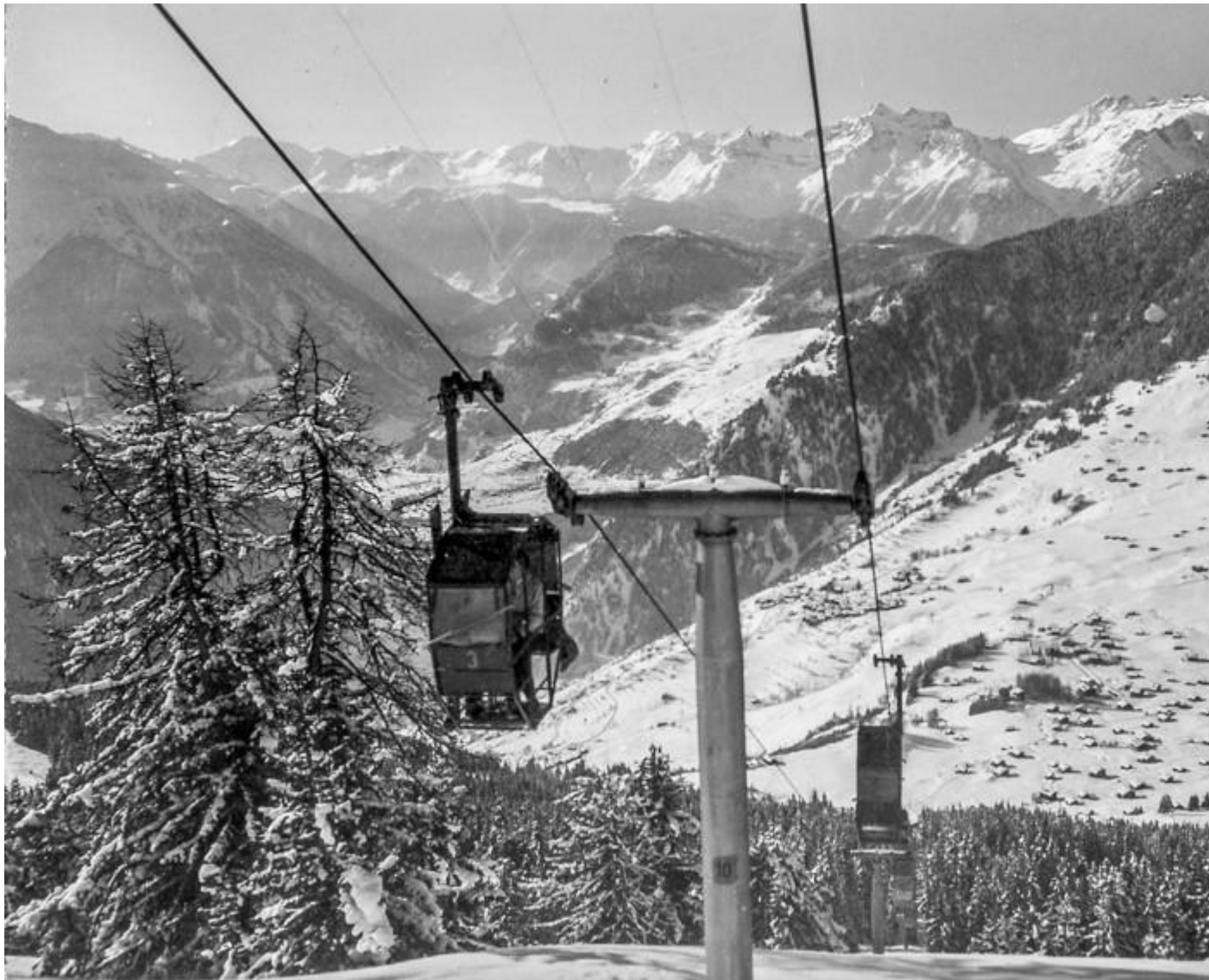
Le pylône n°22 (numéroté comme étant le dixième) sonne le glas du passage à travers la forêt. (Commune de Bagnes - DR Gyger & Klopfenstein Adelboden)
