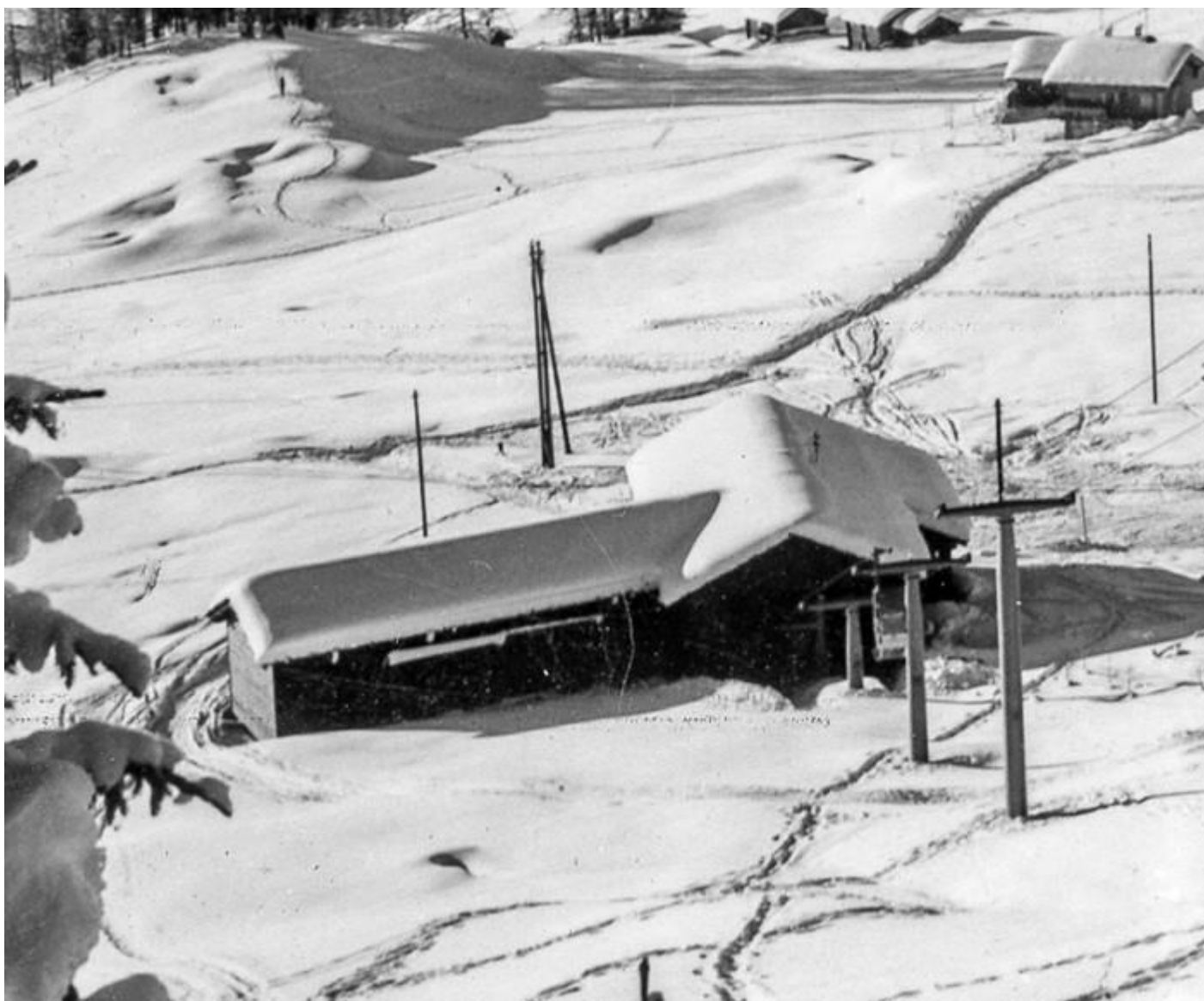
La neige recouvre tout et les traces encerclent un petit chalet de bois faisant office de départ. (Commune de Bagnes - DR Darbellay Martigny)
