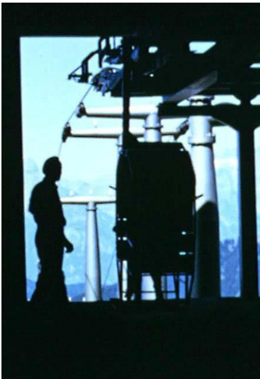
Une fois désolidarisée du câble, un employé arrête la benne pour laisser descendre ses passagers. (DR Roland Muller, Médiathèque Valais - Martigny)
