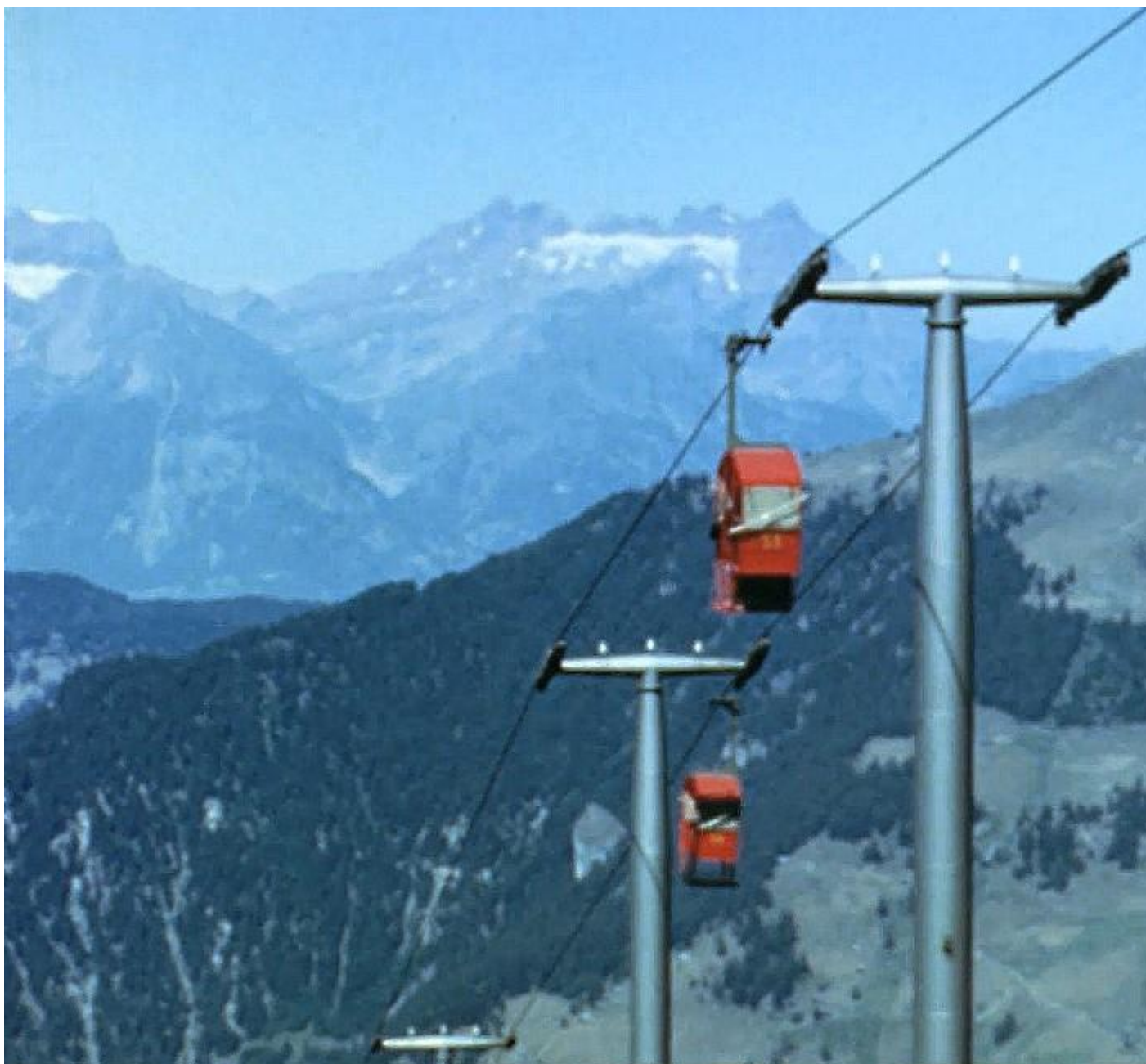
Les derniers pylônes rétablissent l'horizontalité de la pente. (DR Roland Muller, Médiathèque Valais - Martigny)
