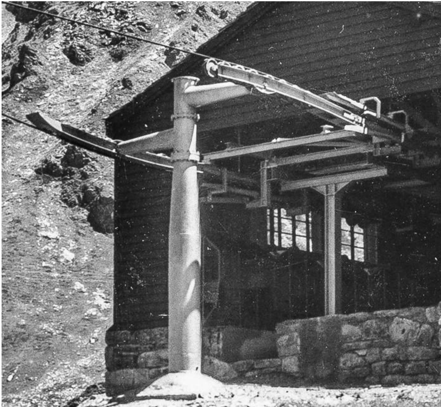
Pour observer le curieux pylône support-compression et les rails de débrayage accueillant la pince. (Commune de Bagnes - DR Gyger & Klopfenstein Adelboden)
