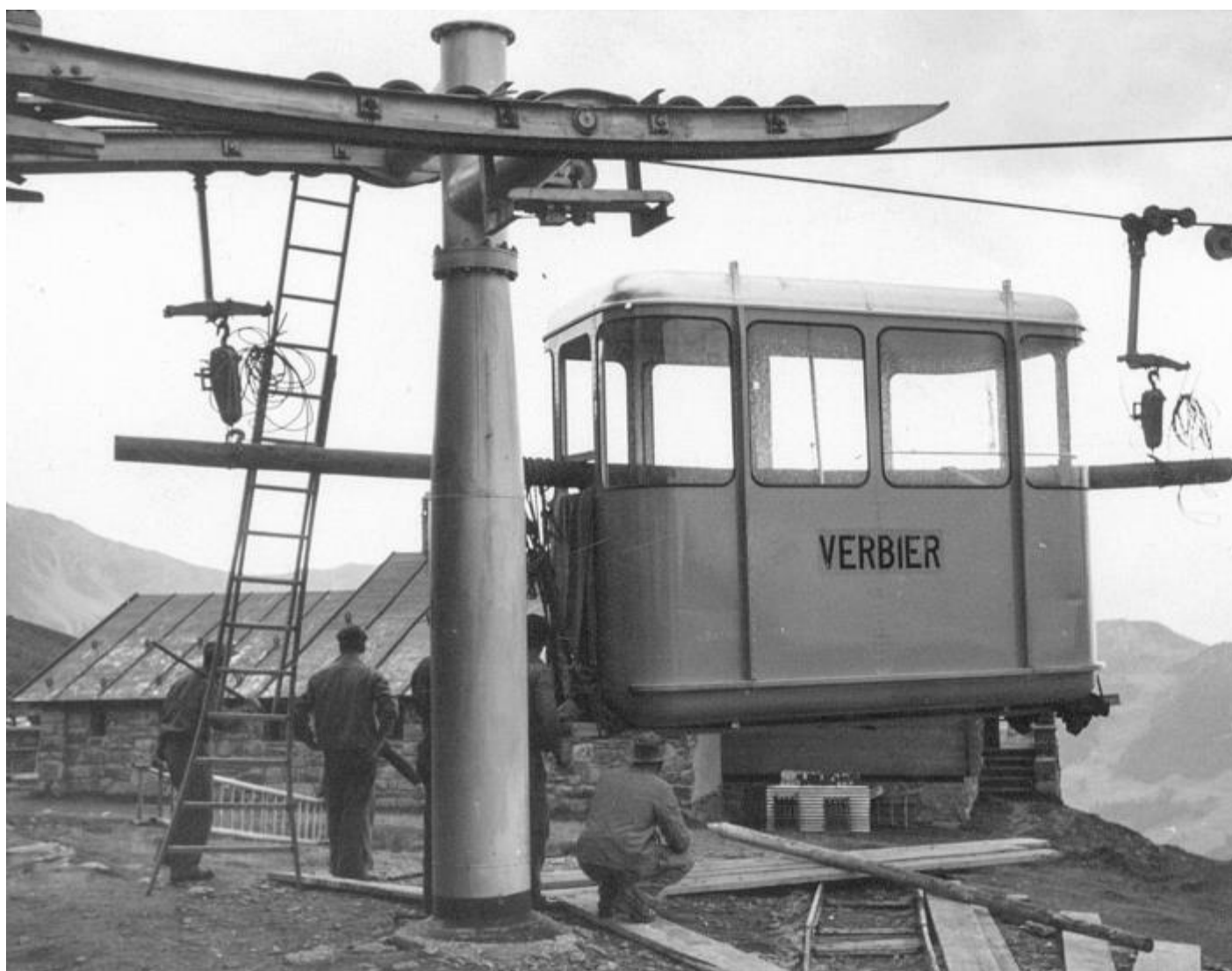
Une fois aux Ruinettes, la cabine est décrochée puis entreposée dans les environs dans l'attente d'être finalement liée au téléphérique définitif. (Téléverbier)
