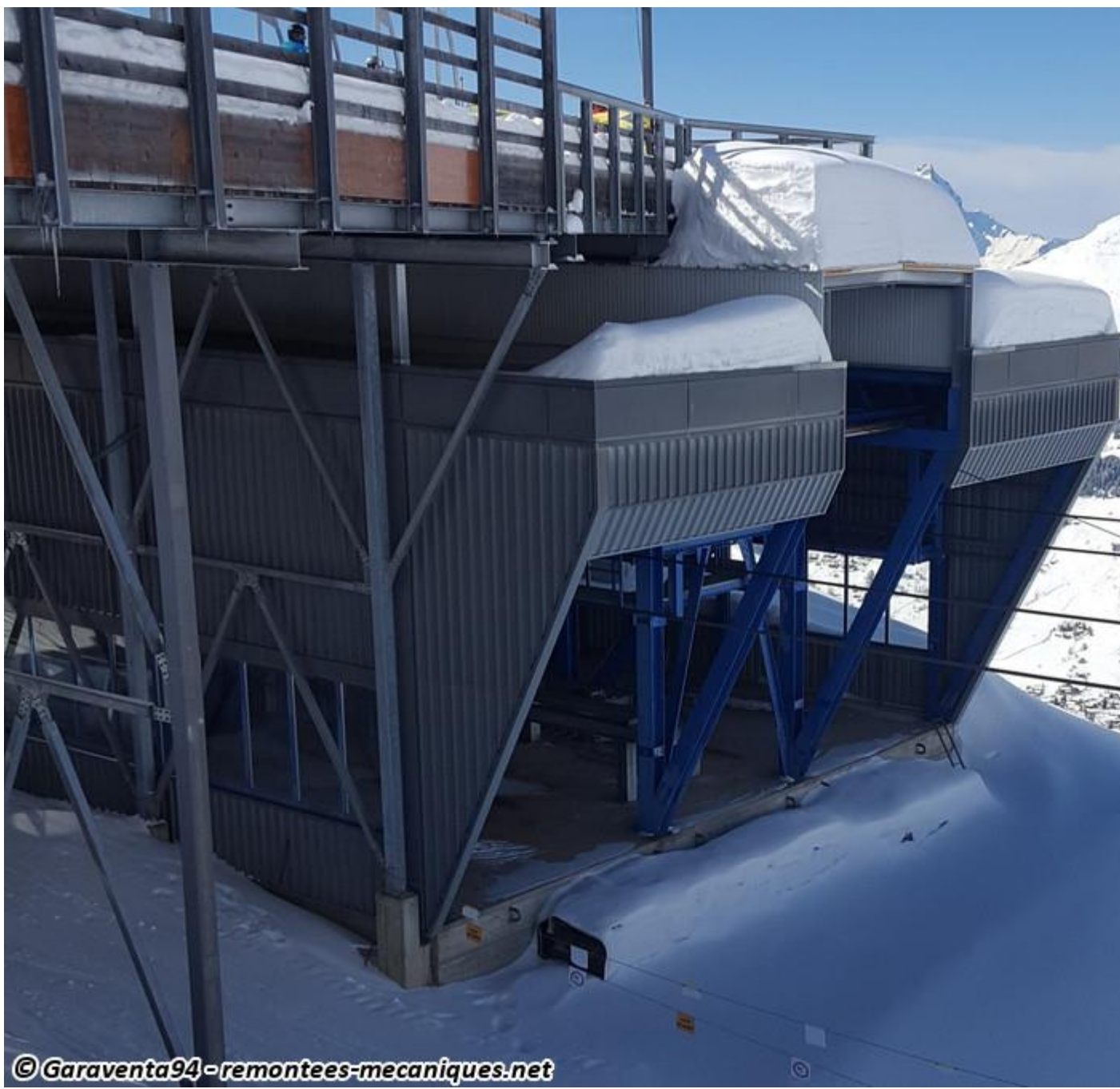
Entrée et sortie des cabines.
