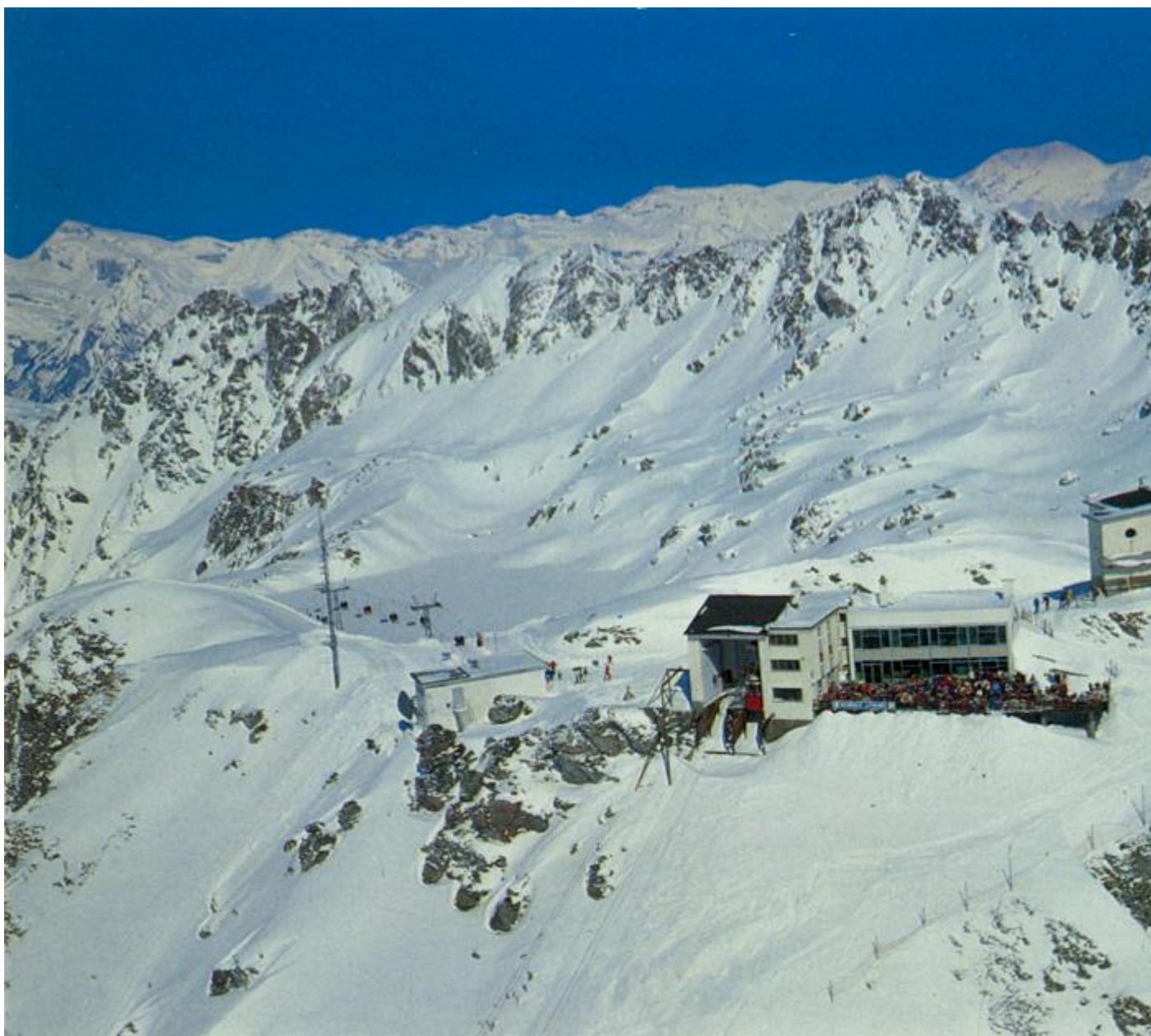
Les deux téléphériques TRA et TAMG et le télésiège du Lac des Vaux se réunissent sur la Crête des Attelas. (Collection François Luisier)
