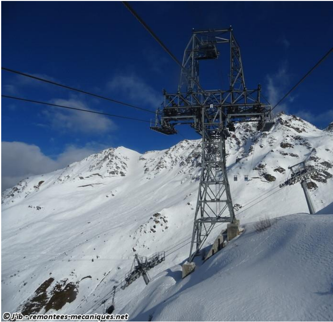
Deuxième pylône qui précède le télésiège de Mayentzet
