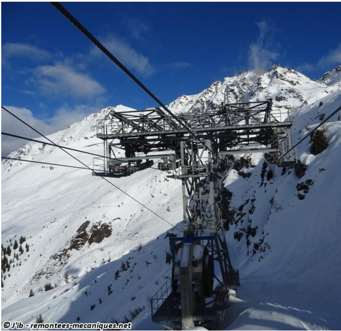
Premier pylône. Au contraire de Montana, ce pylône compression n'est pas lié à la station de départ. Cela s'explique par le fait que la ligne devait rester suffisamment basse en sortie de gare pour que la TCD4 des Attelas puisse la survoler.
