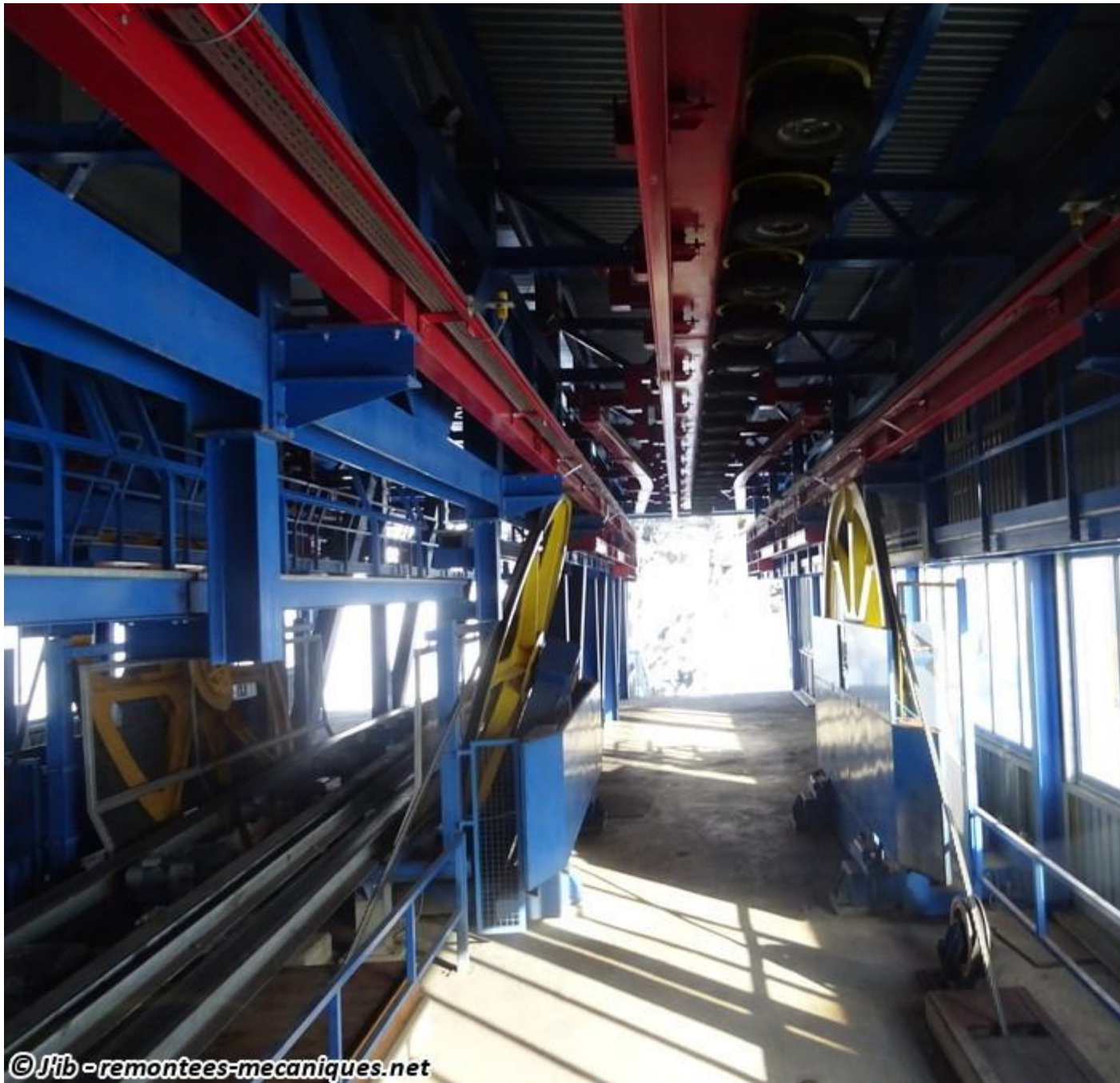
Accélération des cabines et déviation du câble.
