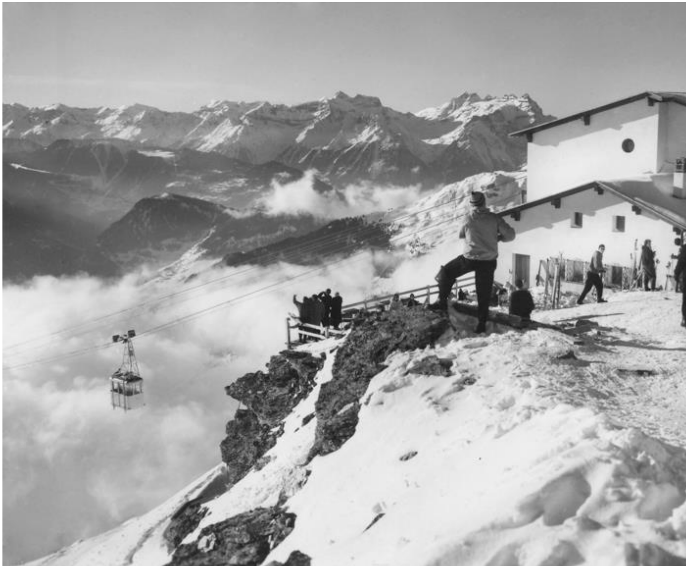
Les Attelas probablement en hiver 1958. On observe la déviation des câbles porteurs dépassant la gare pour se fixer autour d'une tomme d'ancrage coulée au sol. (Collection François Luisier)
