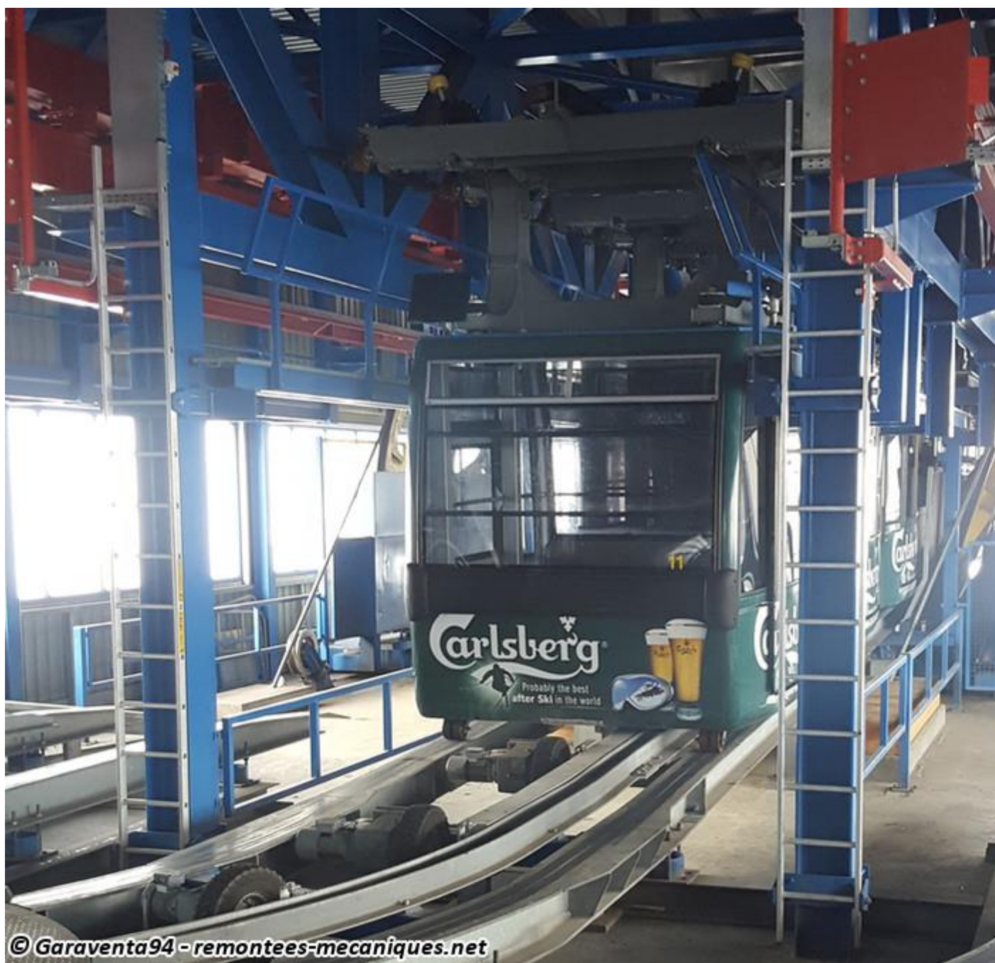
Cabine dans le garage, déjà rempli au maximum
