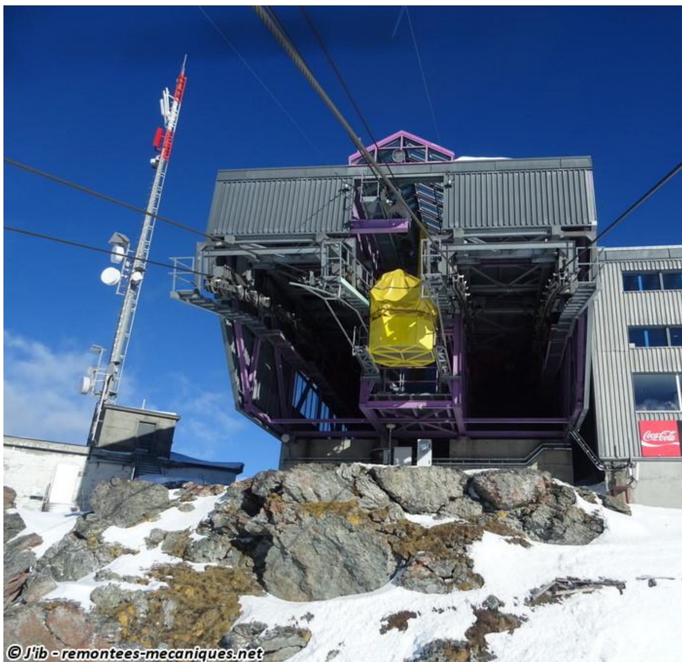
L'ultime pylône support, lié directement à la station, vient rétablir l'horizontalité de la ligne.
